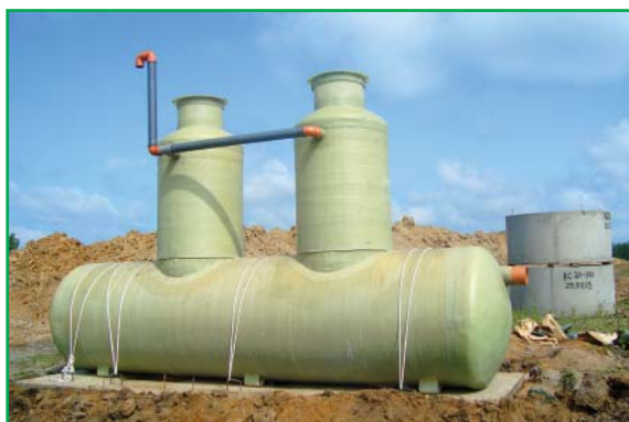
Новосибирск, поселок Толмачево. Логистический комплекс. Ливневые очистные сооружения «ЮНИЛОС», производительность 6 л/с
