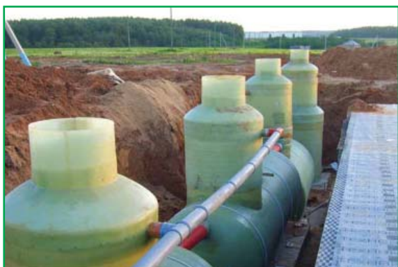
Московская область. Логистический комплекс. Ливневые очистные сооружения «ЮНИЛОС», производительность 15 л/с
